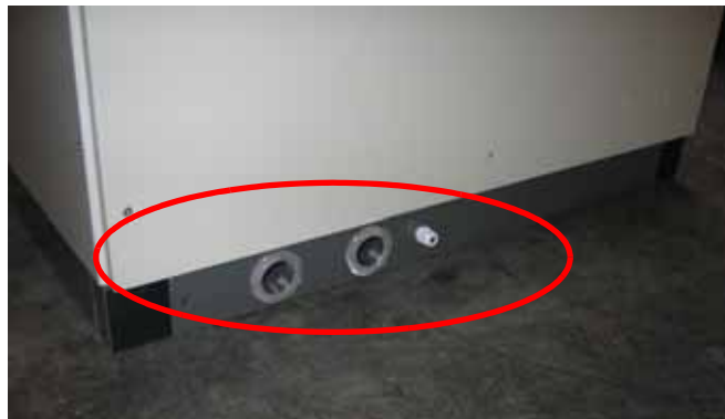
Abbildung 3-6 Position der Kabeldurchführungen
